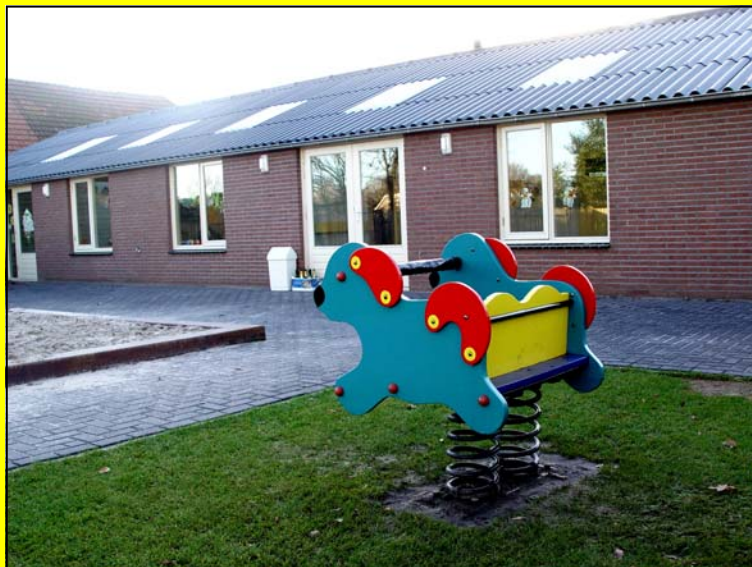
Het nieuwe en ruime onderkomen van de Debberkes in Esbeek. De ombouw van varkensstal tot moderne peuterspeelzaal kwam tot stand door een krachtadig bestuur, vrijwilligers bij de bouw, lokale sponsoren én een forse bijdrage uit het leefbaarheidsfonds.
