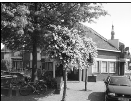
Woningstichting SWH wil deze woningen slopen en herbouwen
